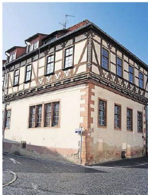
Die Nutzung als Pilgerherberge hilft der Stadt Vacha bei der Erhaltung der historischen Kemenate. Fotos (3): Werner Kaiser
